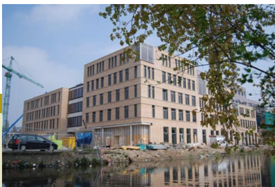
Amsterdam; Oost-Watergraafsmeer, Polderweg, bouw stadsdeelkantoor
